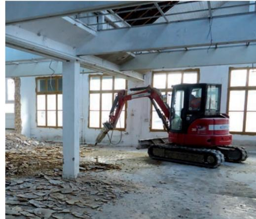
**Materialtrennung: Holz-Zementboden wird von der Betondecke getrennt damit der Beton rezykliert werden kann.**
