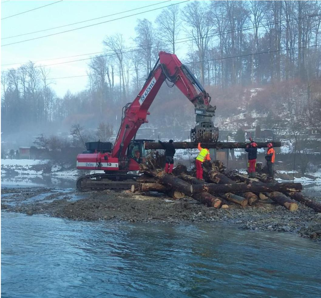
Abbildung 12: Vorbau des Unterbaus einer Einbaugruppe / Segment für die Platzierung 2.5 m unter dem Wasserspiegel, stark angeströmt (Aare in Bern).
