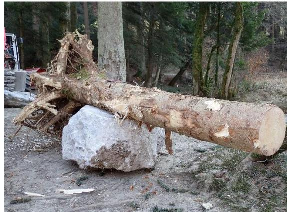
Abbildung 17: Befestigter Wurzelstamm auf Ankerstein
