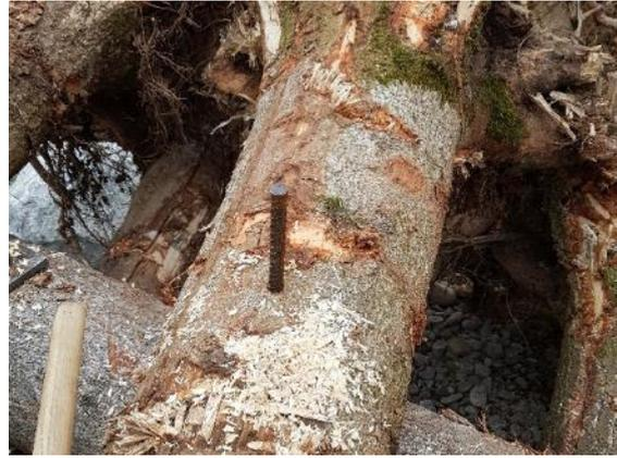
Abbildung 15: Armierungseisen als Nagelverbindung
