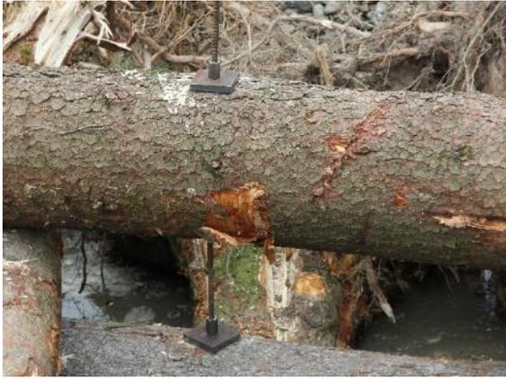
Abbildung 14: Dywidag Stabspannsystem mit Unterlagscheibe und Mutter
