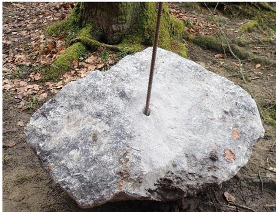
Abbildung 16: Felsanker mit Ankerstange in Blockstein
