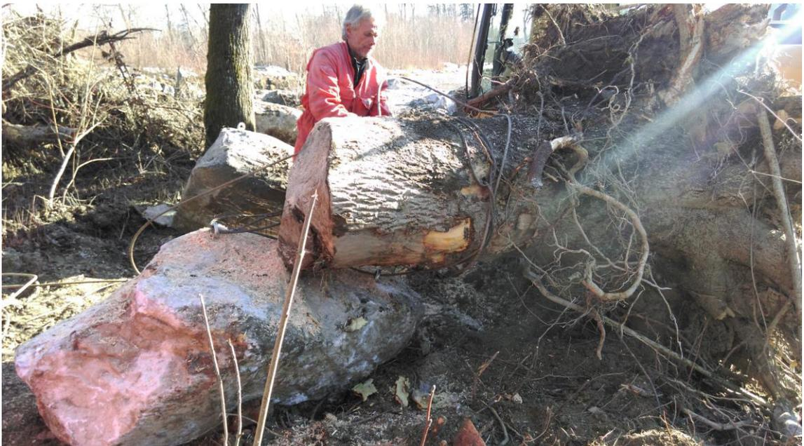
Durch- und Umschlaufen des Wurzelstocks mit dem Stahlseil (Foto Kästli Bau AG)
