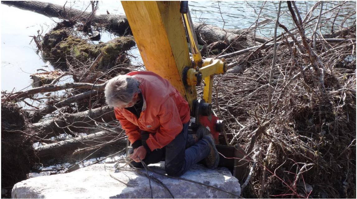
Befestigung des Stahlseils am Blockstein resp. der Ringmutter (Foto Kästli Bau AG)
