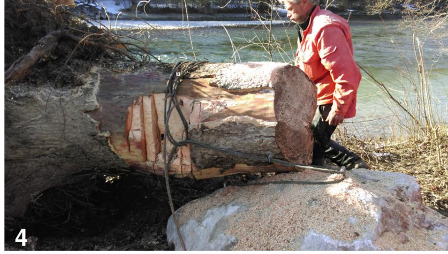
4 Beide Drahtseile einschlaufen und mit klemme sichern. Erster Blockstein einbinden.
