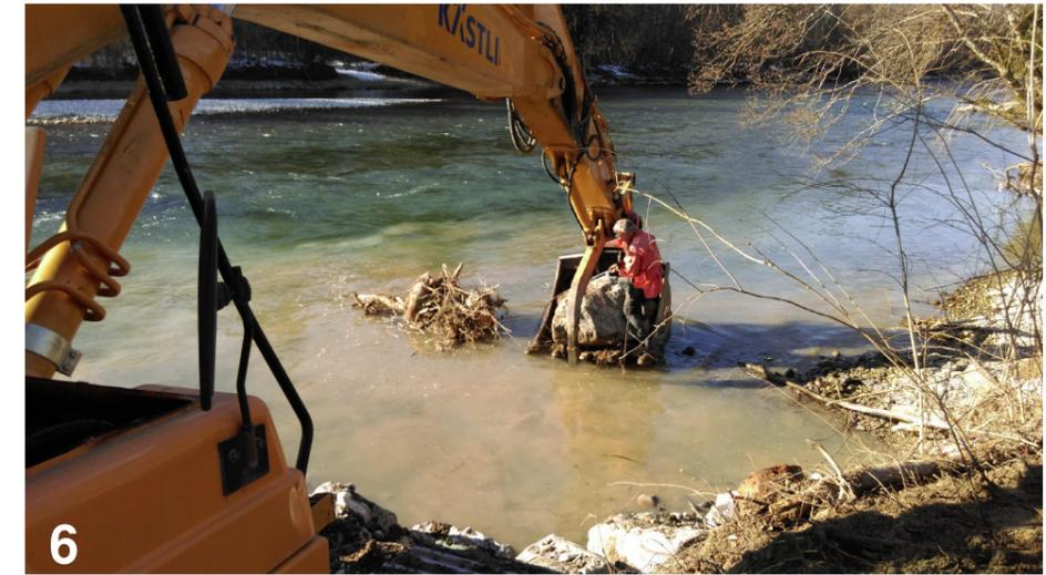
6 Zweiten Stein neben Wurzelstock einschlaufen und mit Klemme befestigen.
