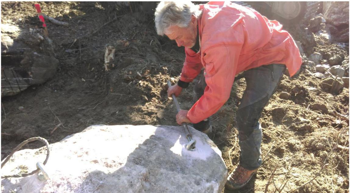
Einsetzen des Felsankers, anbringen und vorspannen der Ringmutter (Foto Kästli Bau AG)
