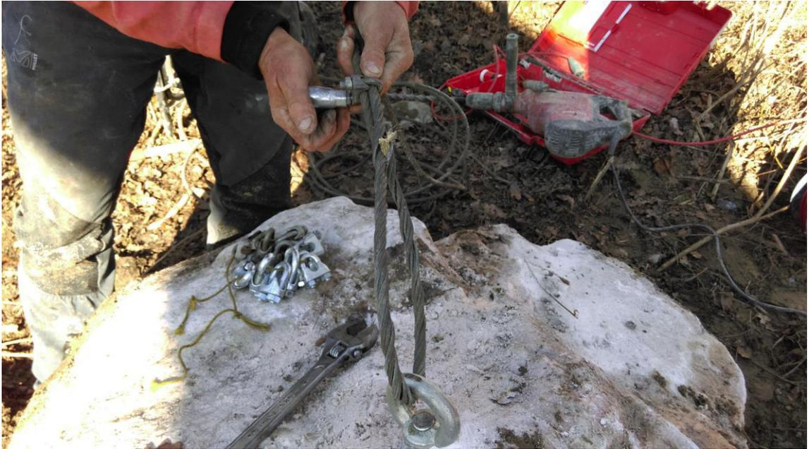
Befestigen des Drahtseils an der Ringmutter (Foto Kästli Bau AG)
