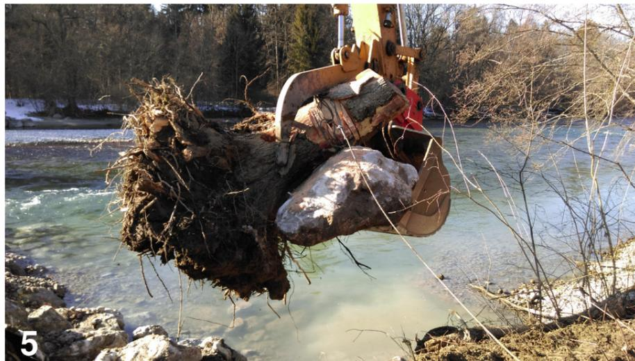
5 Hybride mit einem Stein und einem losen, am Stamm befestigten Seil an Zielort legen.
