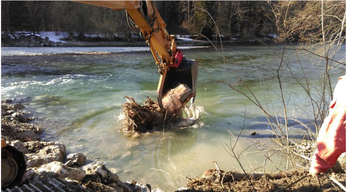
Vorsichtig wird der Stein in die vorbereitete Grube gelegt. (Foto Kästli Bau AG)
