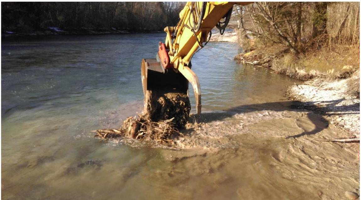
Der Blockstein wird wieder mit Flusskies eingedeckt. (Foto Kästli Bau AG)
