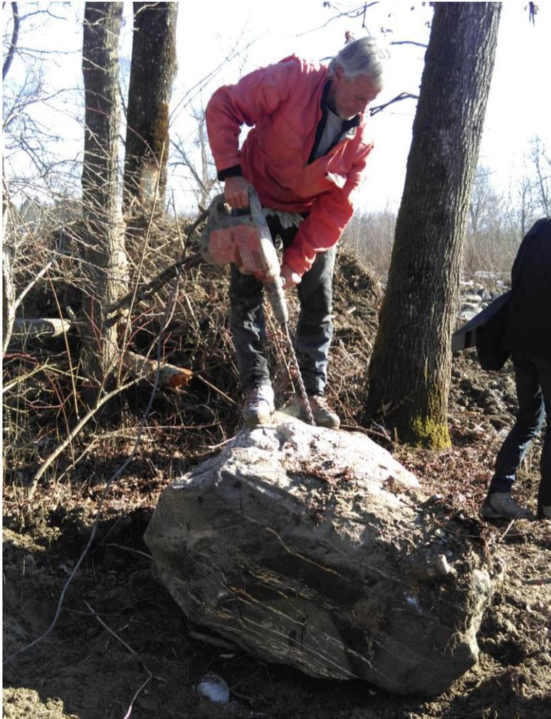
Bohren des Loches in den Blockstein (Foto Kästli Bau AG)
