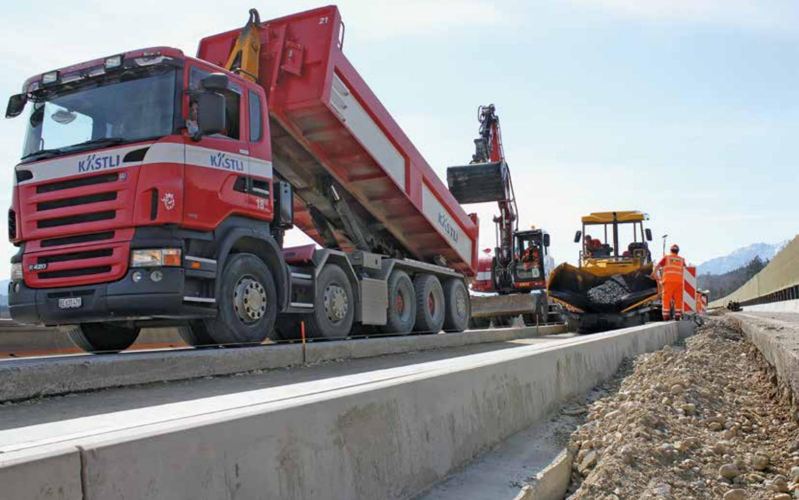
**Effizienter Materialkreislauf: Über 50'000 m<sup>3</sup> Beton- und Asphaltgranulat konnten für die Produktion von neuem Beton und Asphalt auf der A6 wiederverwertet werden.**
