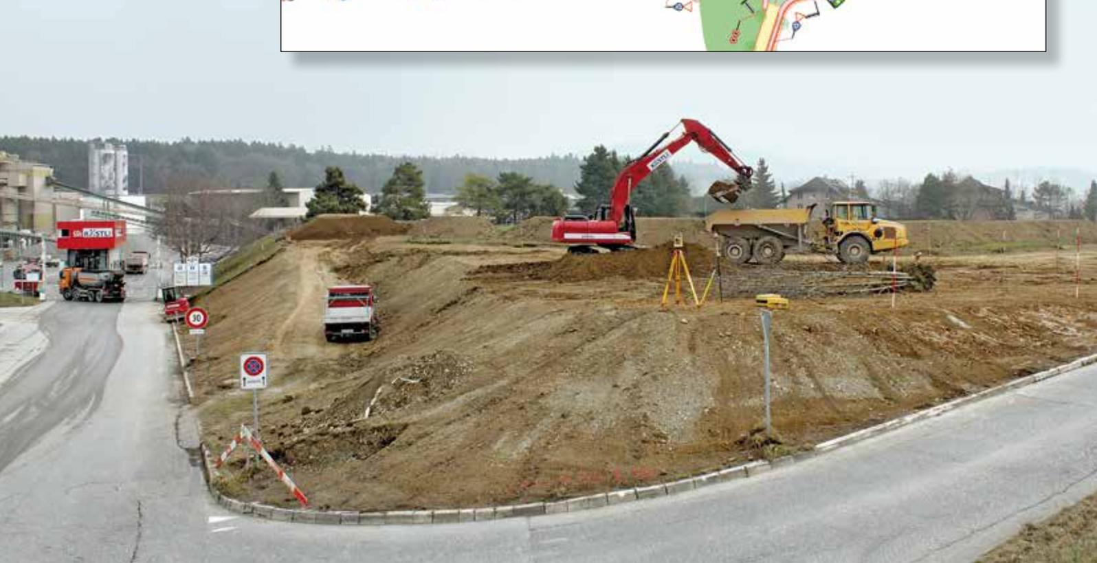
**Baustart März 2016: Mit den ersten Aushub- und Erdarbeiten entstehen eine provisorische Werkzufahrt und ein Hilfskreisel. Beide werden nach der Fertigstellung des eigentlichen Kreisels (vgl. Plan oben) wieder zurückgebaut.**
