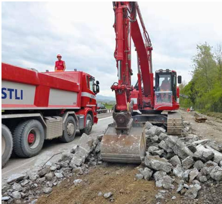
**Wo Neues entsteht, muss Altes weichen: Nach über 40-jähriger Betriebszeit werden sämtliche Fahrbahnen, Mittel- und Pannestreifen, Werkleitungen, Mauern, Brücken sowie Über- und Unterführungen der A6 zwischen Rubigen und Spiez erneuert und an die geltenden Sicherheits- und Umweltnormen angepasst.**
