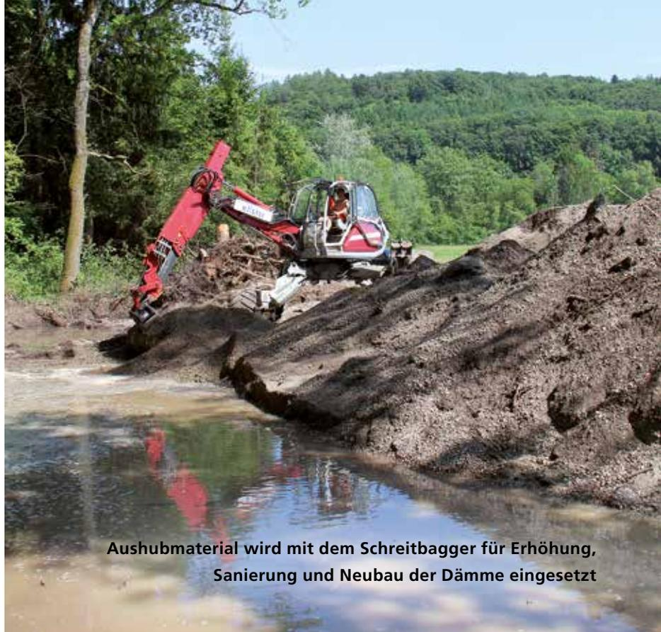
**Aushubmaterial wird mit dem Schreitbagger für Erhöhung, Sanierung und Neubau der Dämme eingesetzt**
