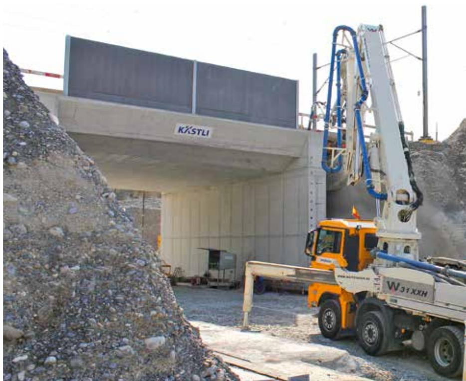
Hinterfüllung der Seitenwände mit Recyclingbeton.
