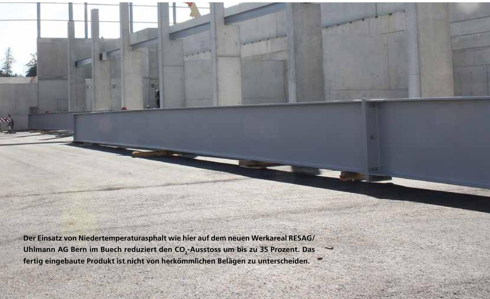
**Der Einsatz von Niedertemperaturasphalt wie hier auf dem neuen Werkareal RESAG/Uhlmann AG Bern im Buech reduziert den CO<sub>2</sub>-Ausstoss um bis zu 35 Prozent. Das fertig eingebaute Produkt ist nicht von herkömmlichen Belägen zu unterscheiden.**
