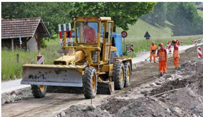
**Arbeitsablauf (von oben nach unten): Rückbau des alten Belags; Mixed-in-place: Auffräsen des Strassenunterbaus und Einmischen von Zement und Wasser; Grob- und Feinplanie mit Recyclingkies für Belagseinbau.**
