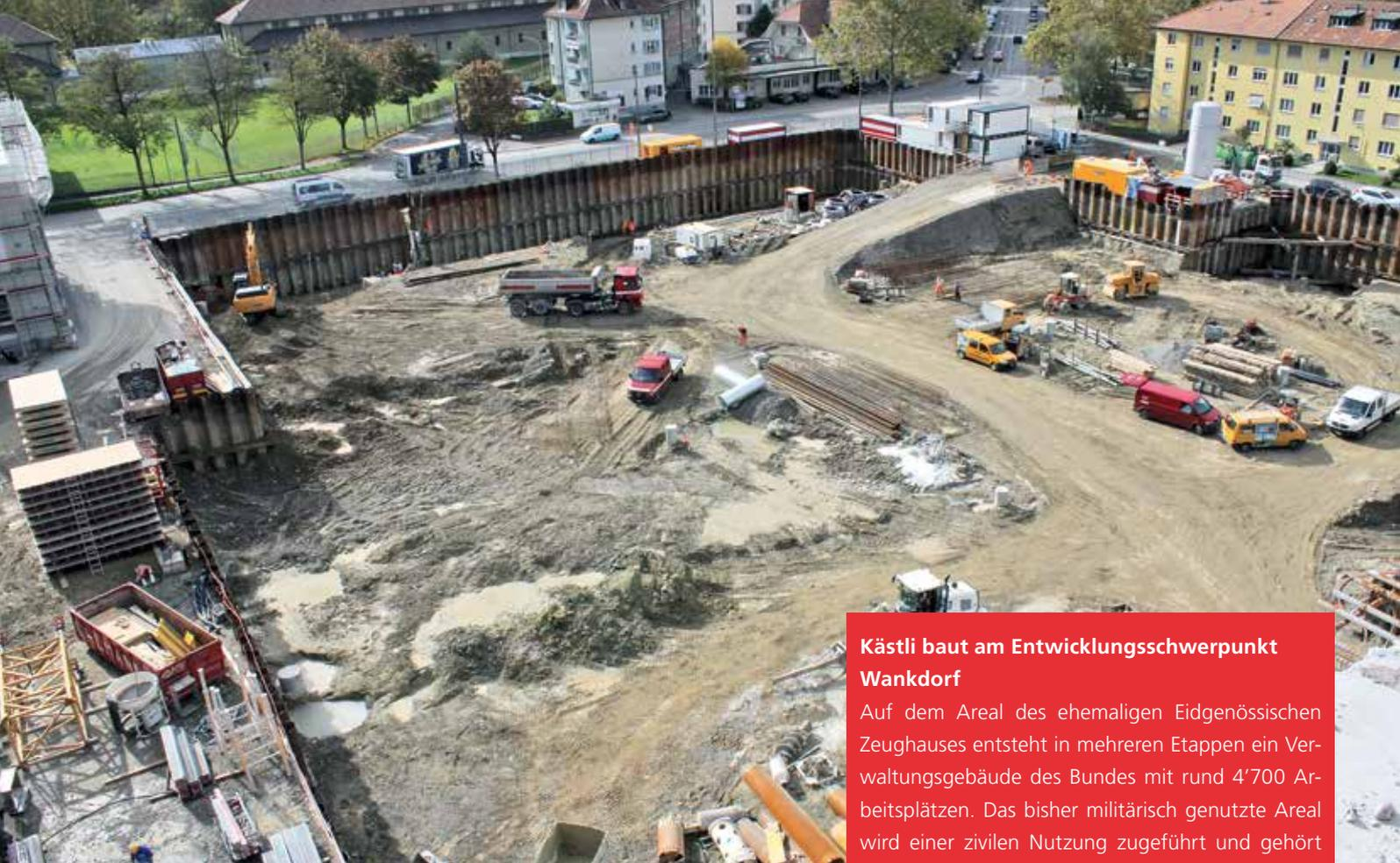
**In der Baugrube mit 10'000 m<sup>2</sup> Spundwand müssen rund 150'000 m<sup>3</sup> Aushubmaterial abtransportiert werden. Bei Abschluss der Aushubarbeiten werden etwa 12'500 LKW die Schmutzsperrle im Bild oben rechts passiert haben.**
