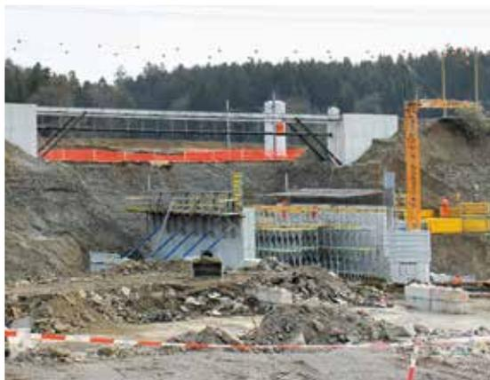
**Die neue Bahnbrücke wurde in kurzer Entfernung zum Durchbruch vorgefertigt.**
