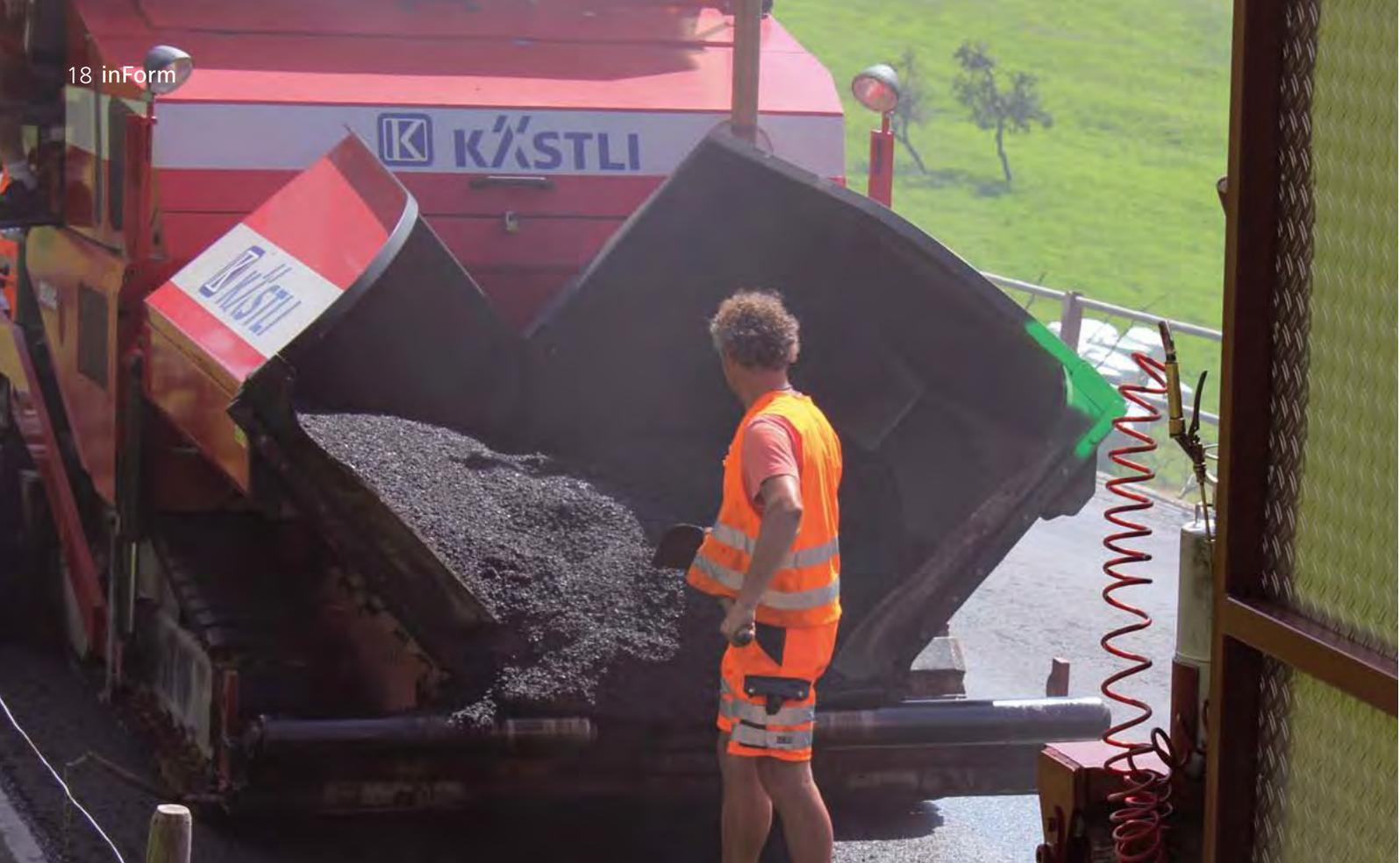
Auf einer Gesamtlänge von über fünf Kilometern wurden 3'000 Tonnen Deckbelag eingebaut. Der Belag wurde von der Kästli Transport AG in Thermomulden transportiert.
