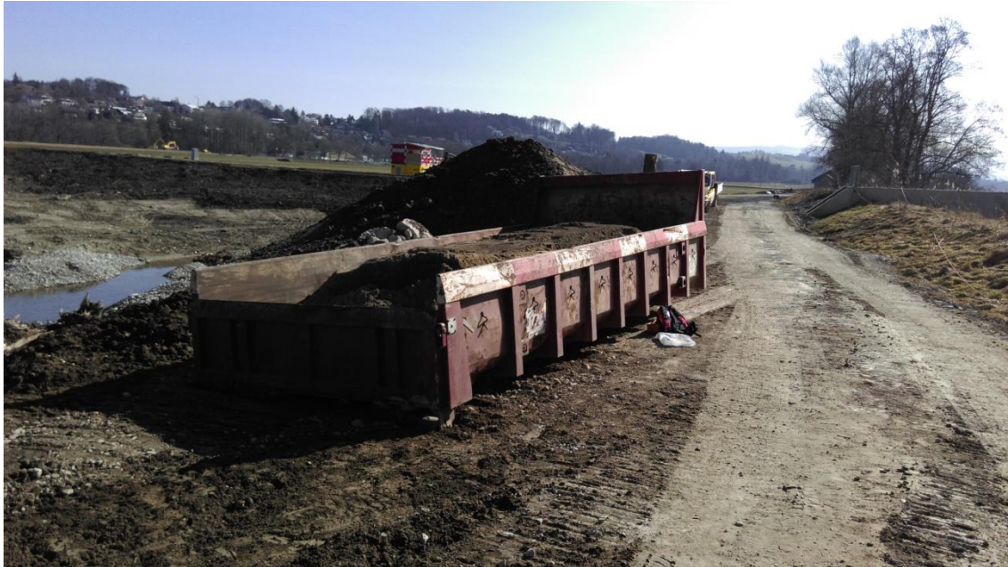
Foto der Abrollmulde auf Baustelle welche das Nistschicht-Material enthält (Foto Kästli Bau AG)
