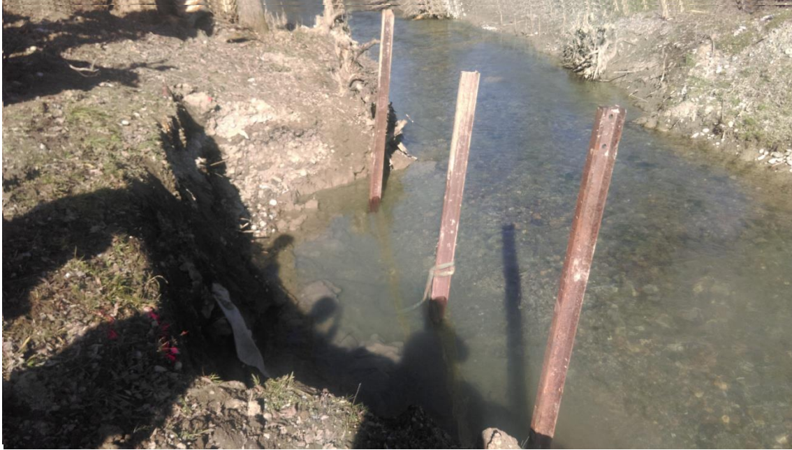
Foto der bereits versetzten Eisenbahnschienen (Foto Kästli Bau AG)
