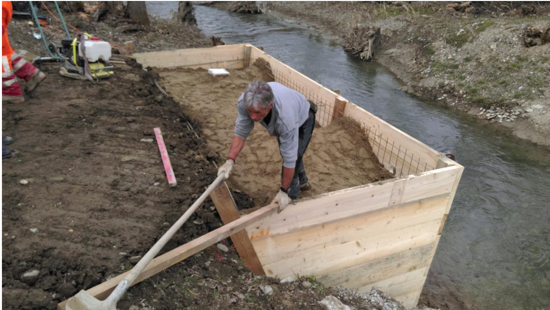
Foto während des Einbringens der Nistschicht (Foto Kästli Bau AG)
