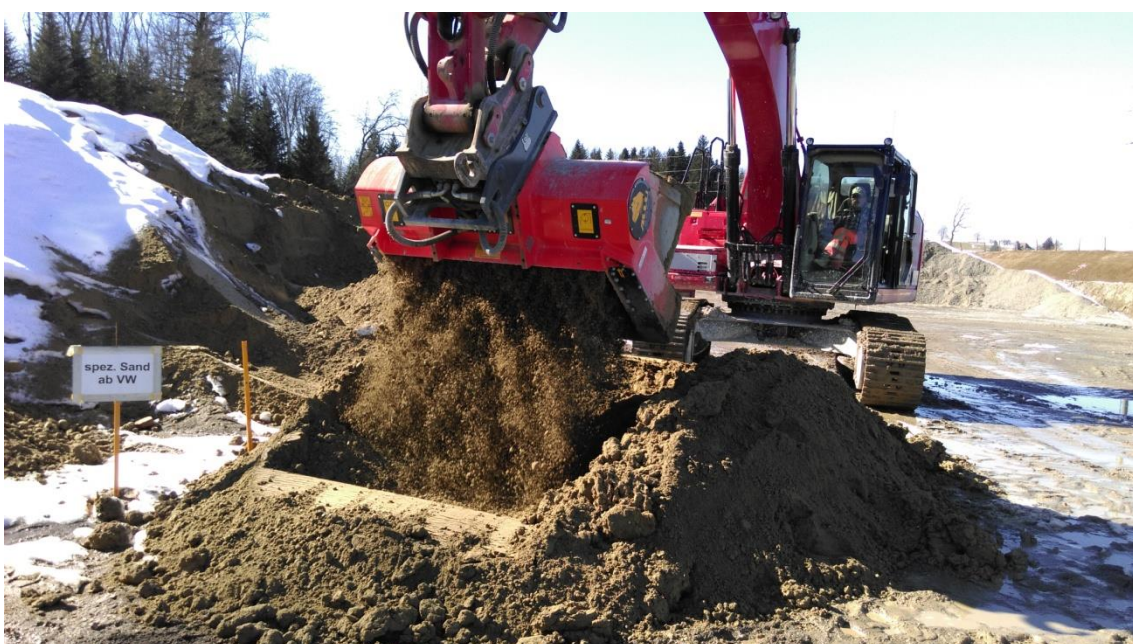
Fotos der Erstellung der Nistschicht-Materialmischung mit Sortierschaufel (Foto Kästli Bau AG)
