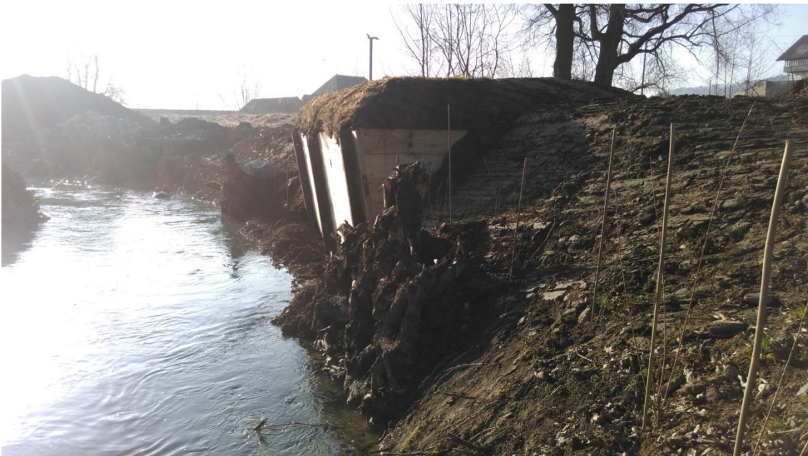
Foto der fertiggestellten Eisvogelwand. Blick in Fließrichtung aufwärts (Foto Kästli Bau AG)
