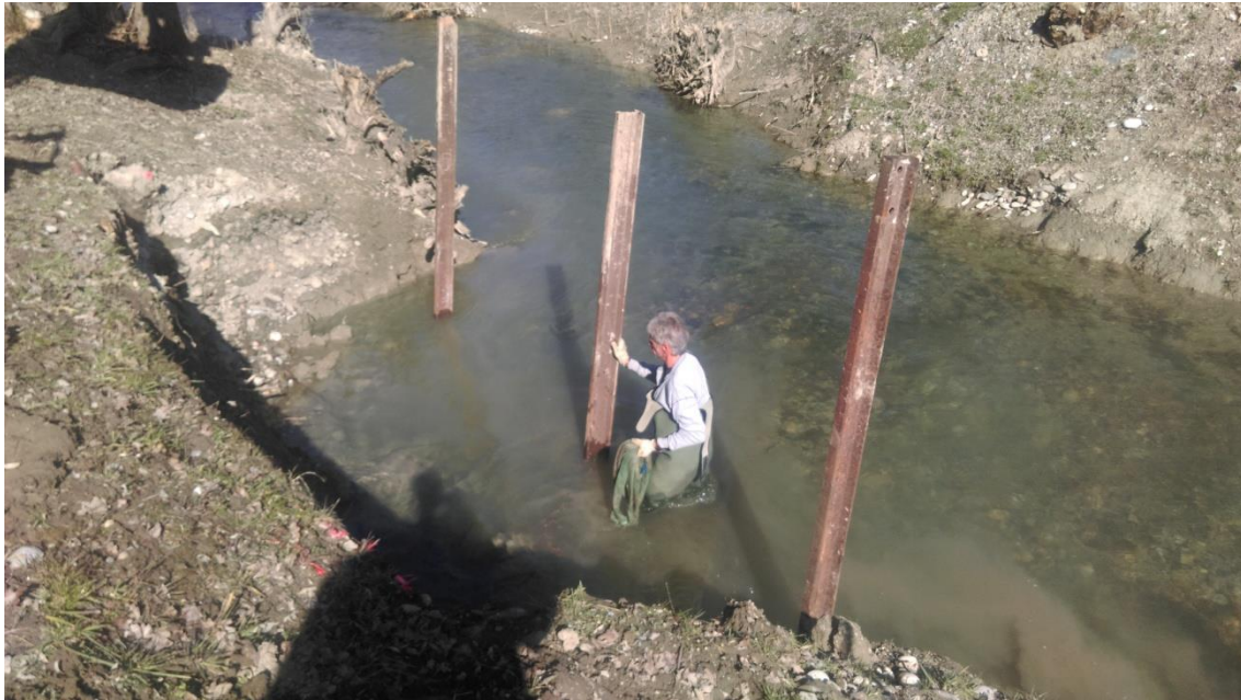
Foto der fertig ausgehobenen Grube und versetzten Eisenbahnschienen (Foto Kästli Bau AG)
