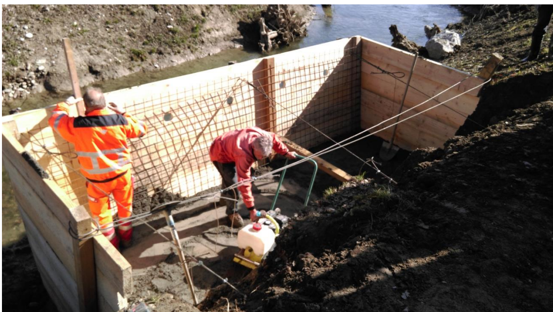
Foto während des Einbringens der Sandstabi (Foto Kästli Bau AG)
