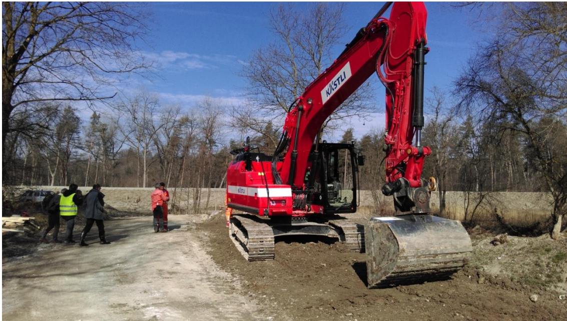
Foto des eingesetzten Baggers (Foto Kästli Bau AG)
