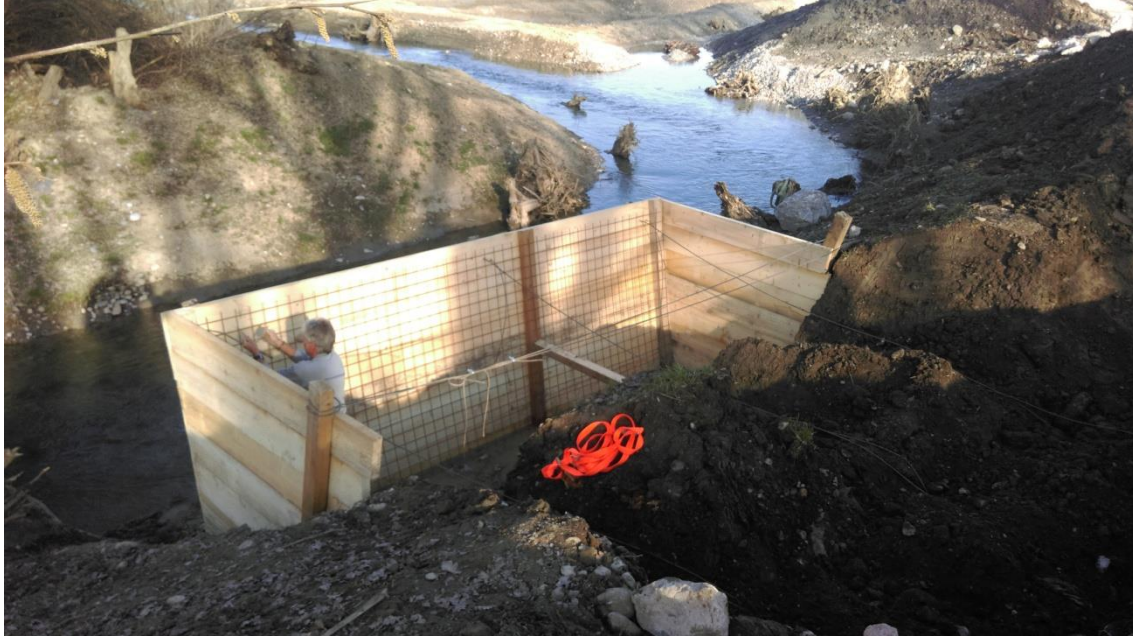
Foto der verlegten, noch nicht abgespannten Drahtseile (Foto Kästli Bau AG)
