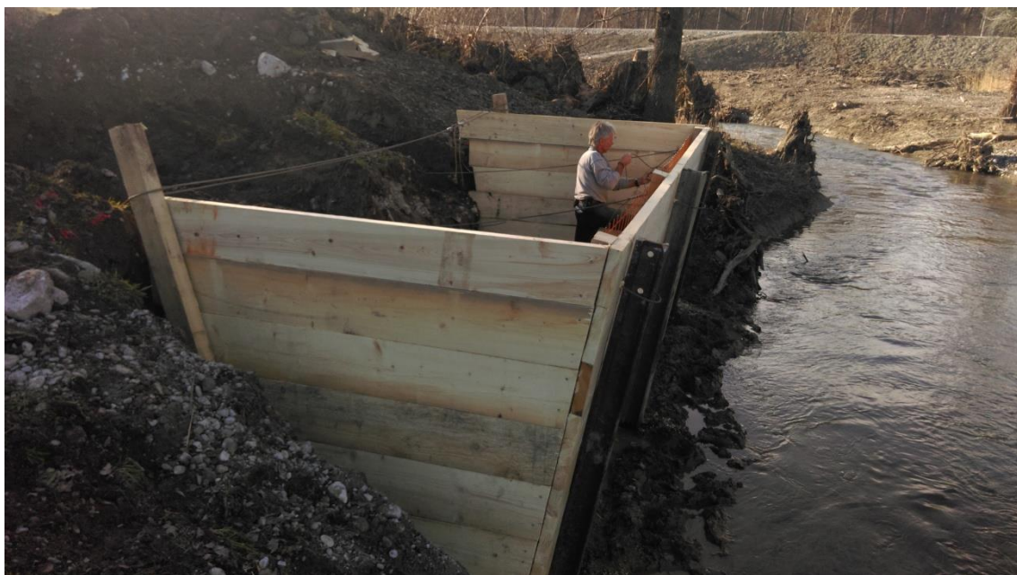
Foto des erstellten Holzkastens (Foto Kästli Bau AG)
