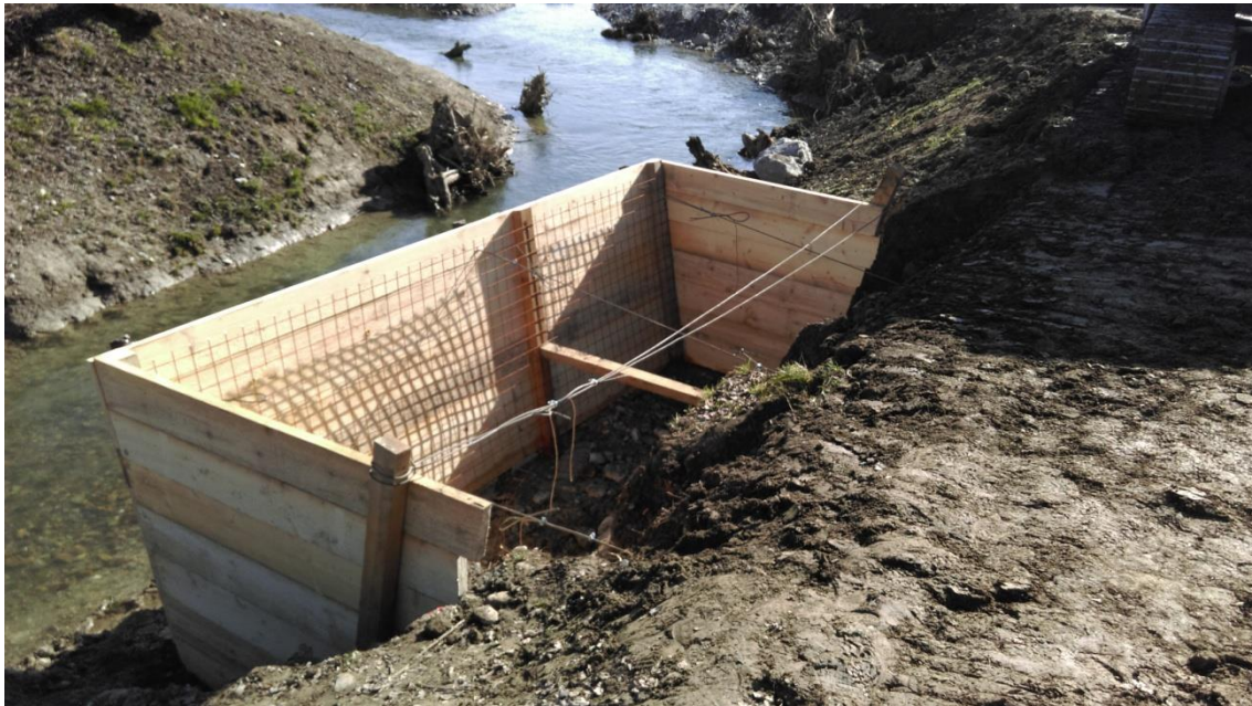
Foto des fertiggestellten und gesicherten Holzkastens (Foto Kästli Bau AG)
